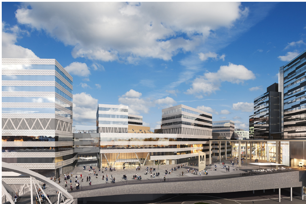
Vy från stjärntorget där SEB:s huvudentré är placerad. Byggnadens fasad har tydliga fönsterband och täta band med vitmönstrat glas.
